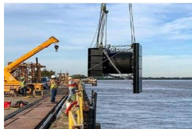
Gambar 2.7 Fender karet tipe sel
