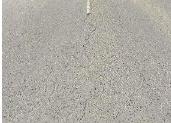
Gambar 2.3 Retak Memanjang
