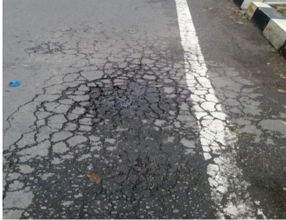
Gambar 2.1 Retak Kulit Buaya
