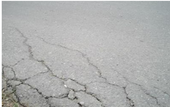
Gambar 2.4 Retak Pinggir
