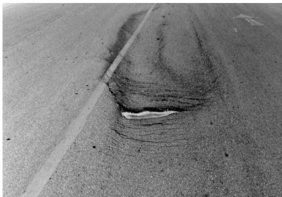
Gambar 2.2 Retak Slip
