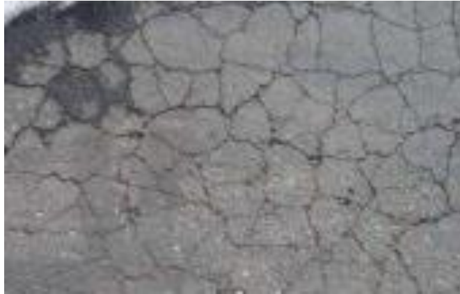
Gambar 2.9 Retak susut
