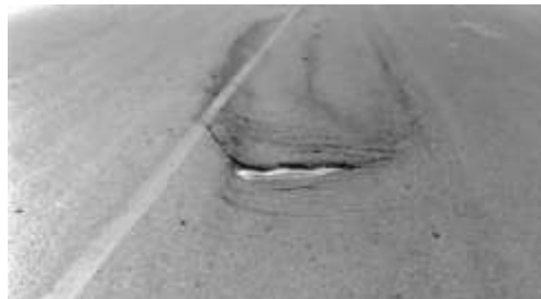
Gambar 2. 12. Kerusakan retak slip atau bentuk bulan sabit
