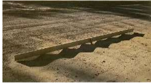
Gambar 2. 1. Jenis kerusakan bergelombang pada jalan
