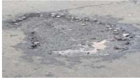
Gambar 2. 13. Pelapukan butiran lepas pada jalan
