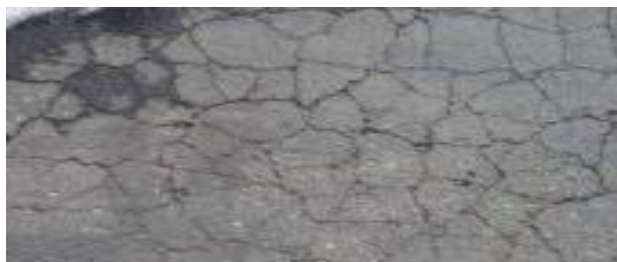
Gambar 2.10 Retak Susut
