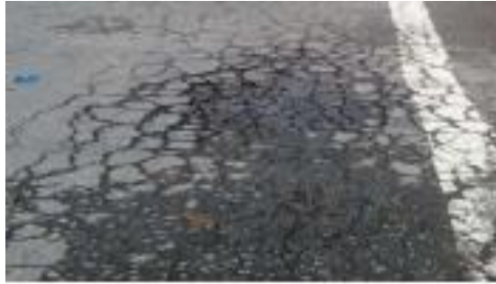
Gambar2.2Retak Kulit Buaya
