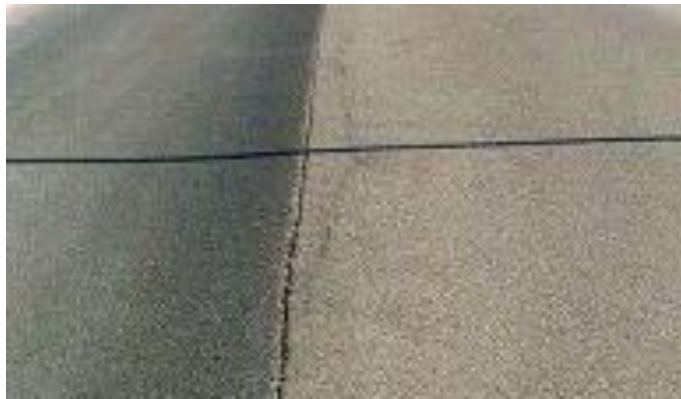
Gambar2.7RetakSambunganJalan
