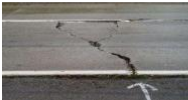
Gambar2.6RetakSambunganBahuPerkerasan
