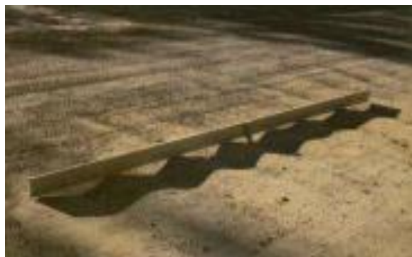
Gambar 2.12 Keriting atau Bergelombang
