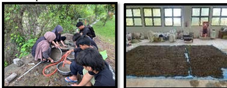
**Gambar 3.6** Proses pencucian dan penjemuran agregat halus
