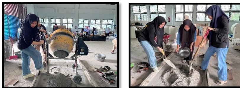
**Gambar 3.14** Proses penuangan adukan dan pencampuran secara manual
